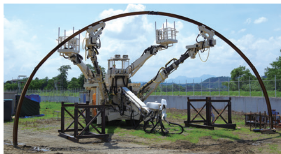
鋼製支保工建込みロボット全景
