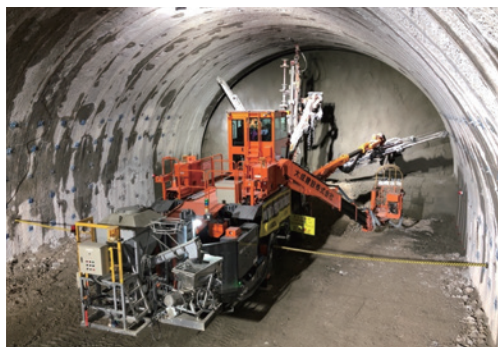
ロックボルト施工状況
