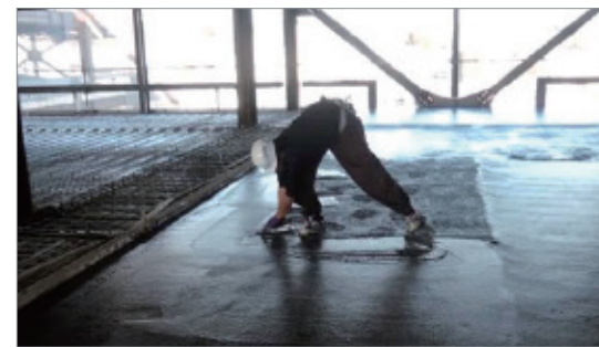
土間工による作業状況
