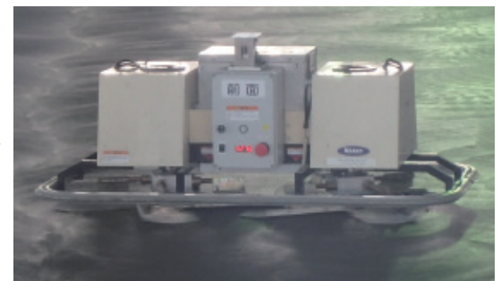
ロボットによる作業状況
