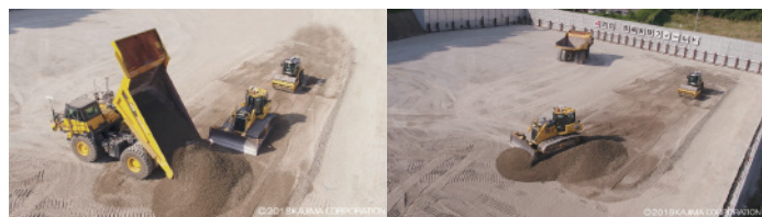
実規模施工実験場での開発状況
