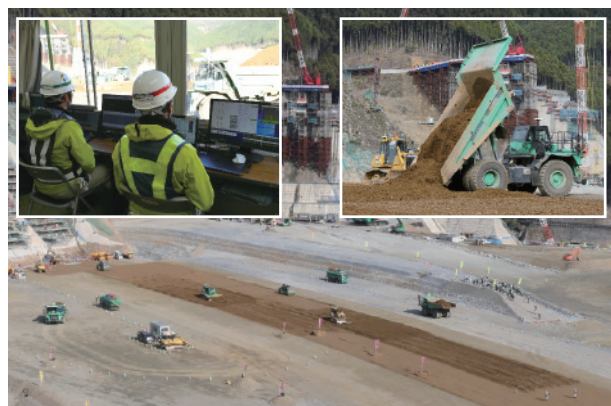
現場実用状況 (@フィルダム 2018年)
