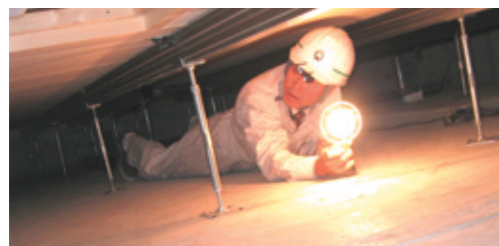
床下点検作業
