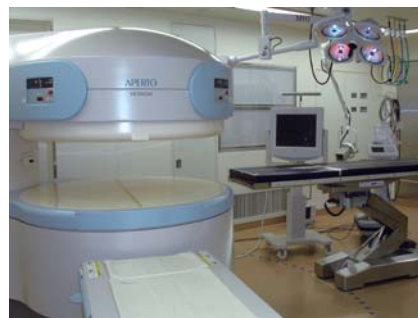
九州大学病院オープンMRI治療室
